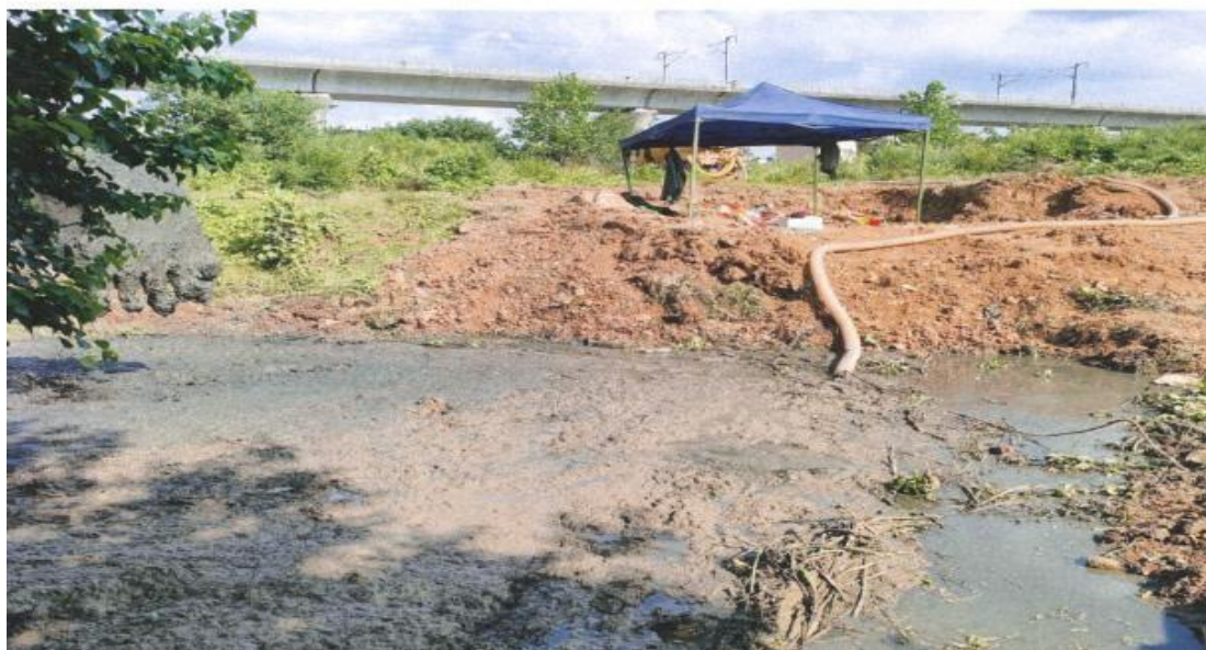
图 4.5 类似项目抽水泵排水
