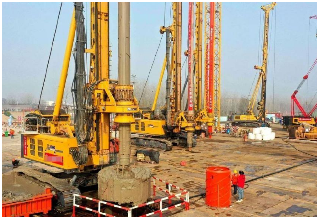
图 5.2 类似项目钻孔灌注桩
