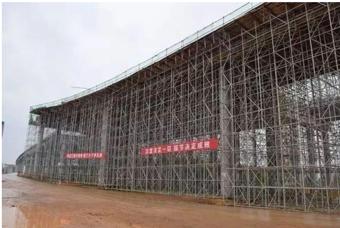
图 5.11 满堂式钢管支架
