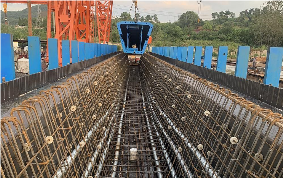
图 5.8 类似项目桥梁构件钢筋
