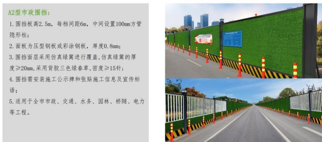
图 4.13 某市标准图集-2.5m 高仿真绿篱压型钢板围挡
