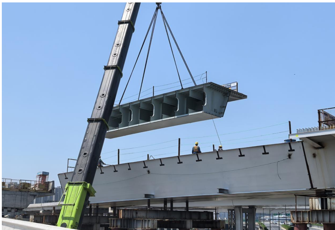
图 5.5 类似项目钢箱梁
