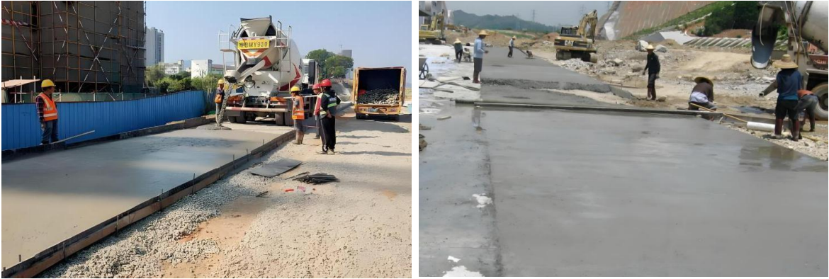
图 4.8 类似项目水泥混凝土路基
