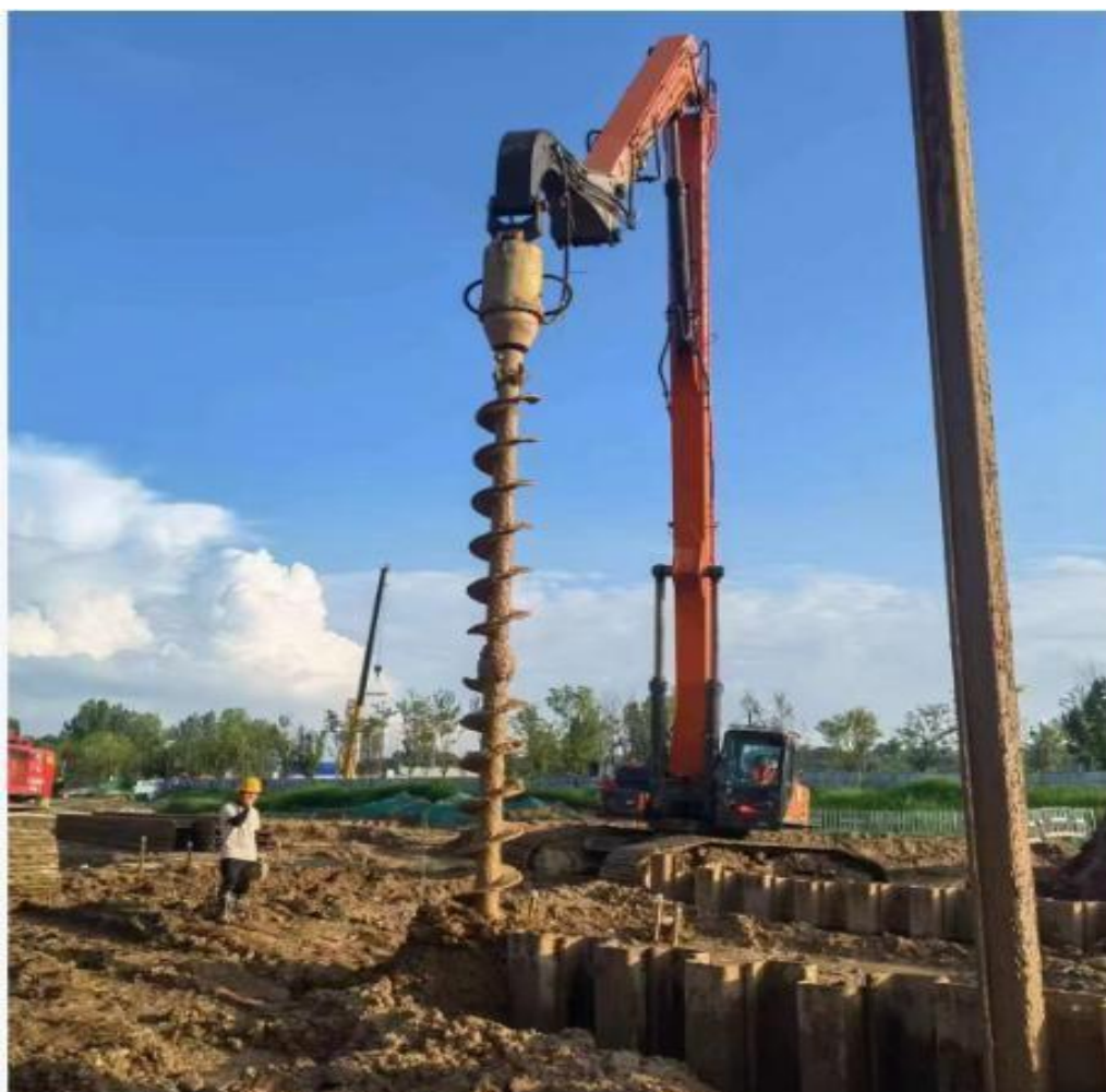
图 4.11 类似项目钢板桩施工
