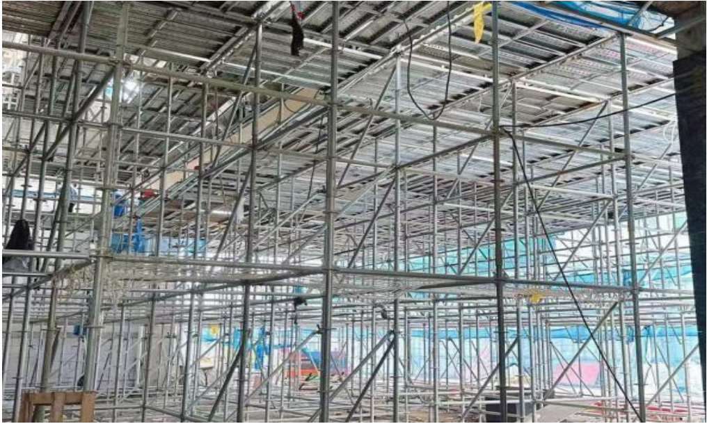
图 3.6 类似项目脚手架现场实景图
