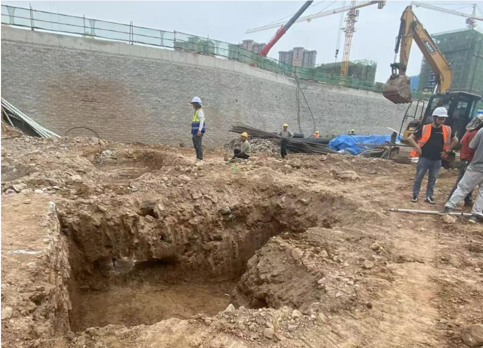
图 3.1 类似项目基坑开挖现场
