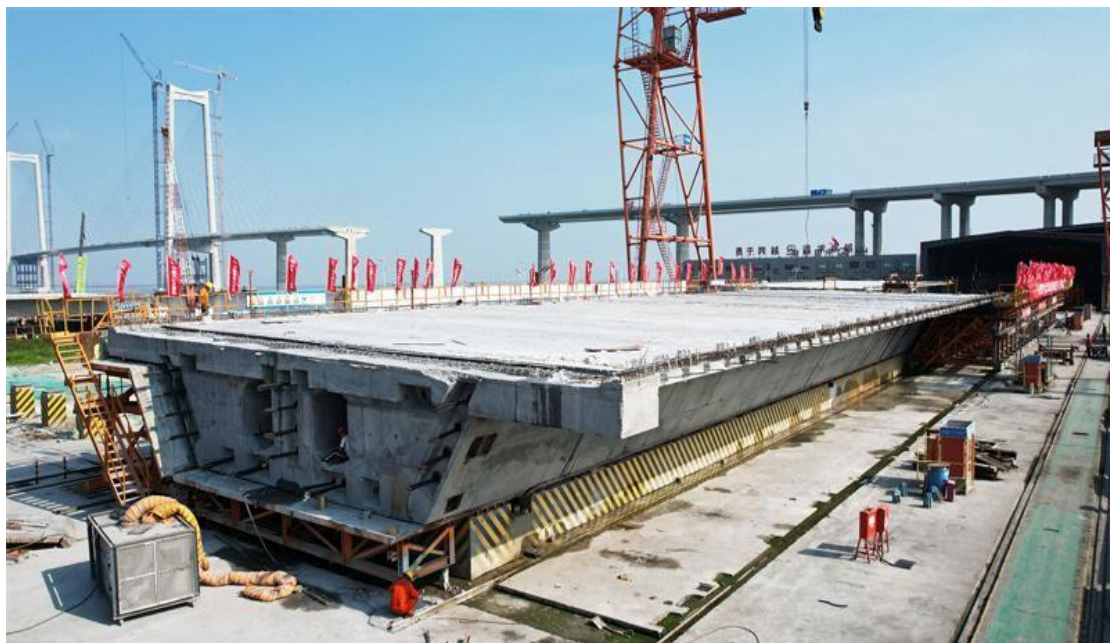
图 5.7 类似项目混凝土箱梁
