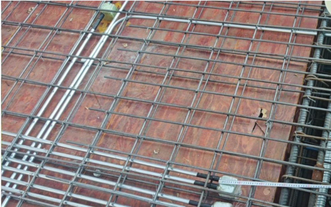
图 3.4 类似项目配管现场施工实景图
