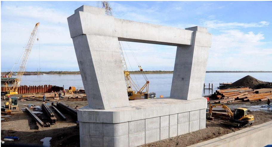
图 5.3 类似项目混凝土墩（台）身
