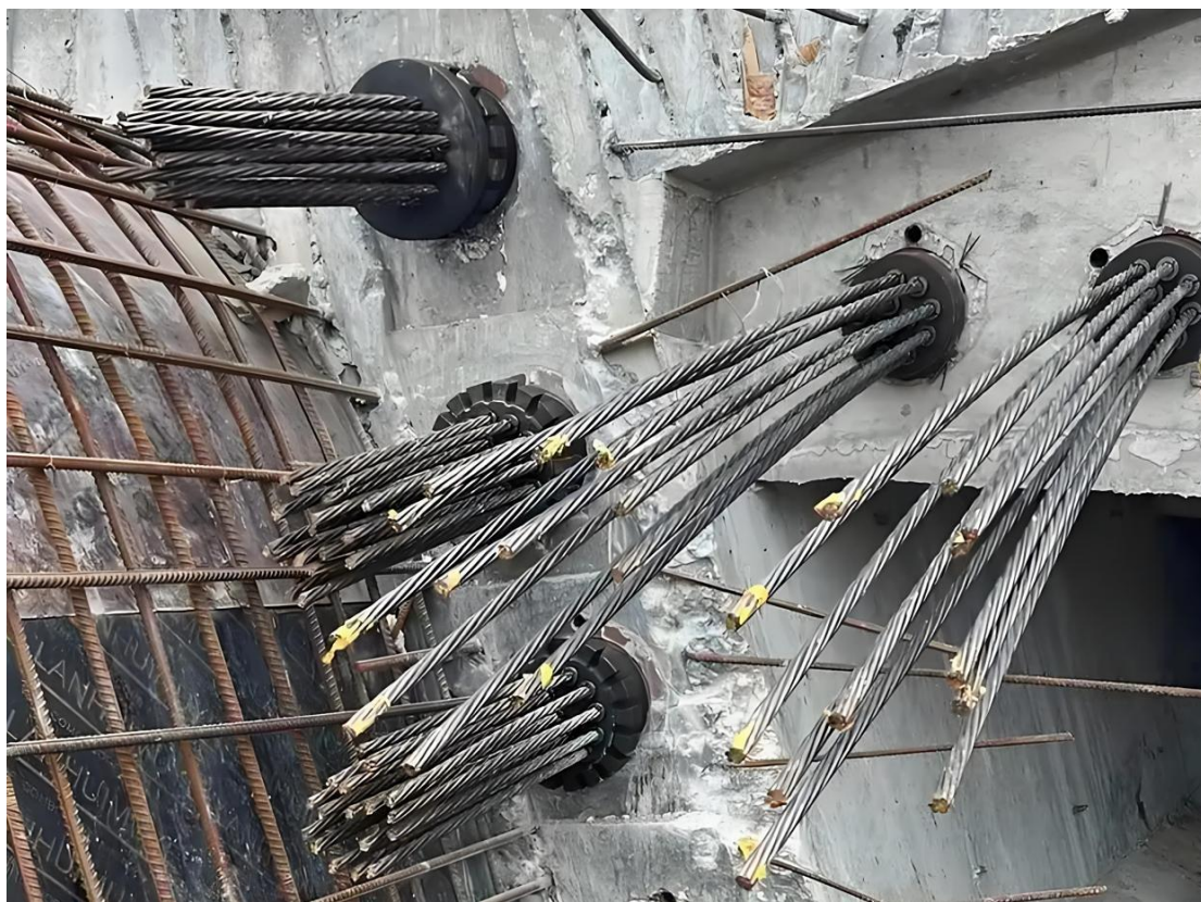
图 5.10 类似项目后张法预应力钢绞线
