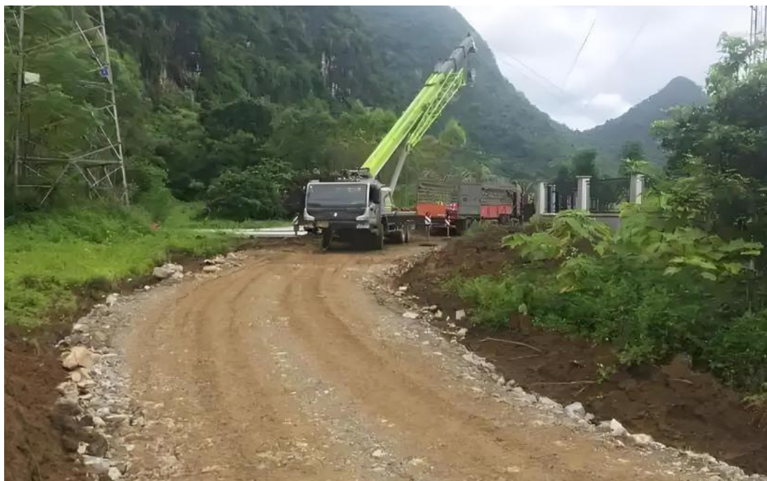
图 4.14 类似项目临时便道
