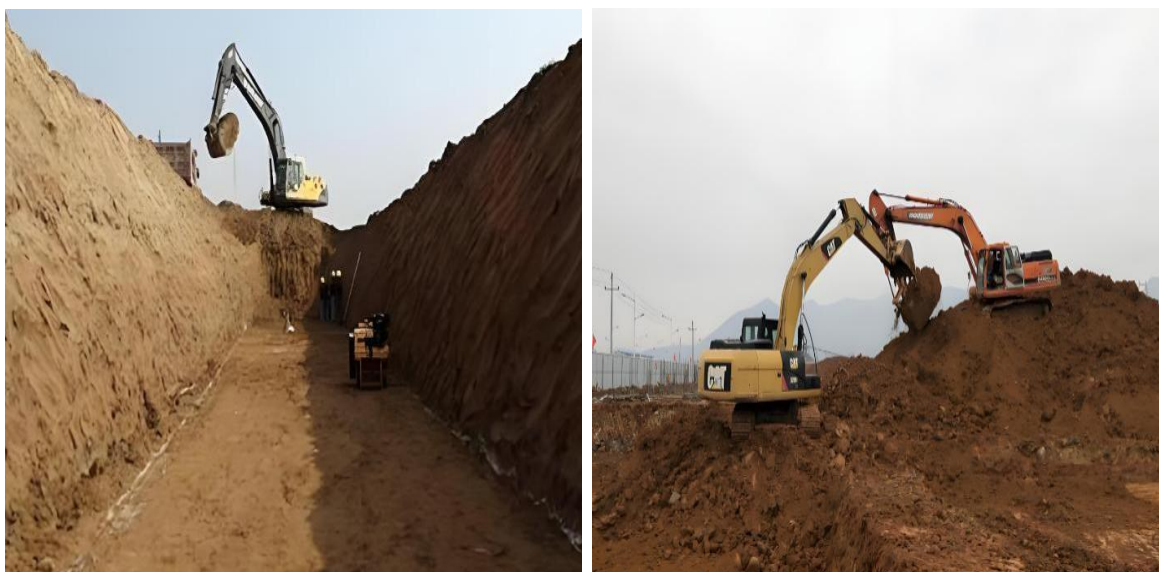
图 4.2 类似项目沟槽开挖
