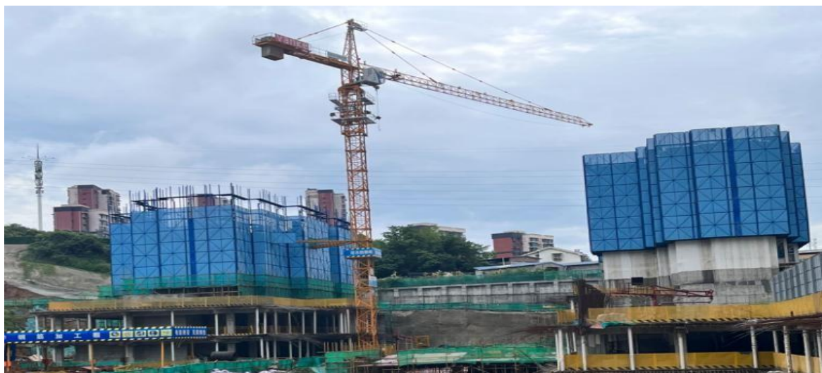
图 3.7 类似项目塔吊现场实景图
