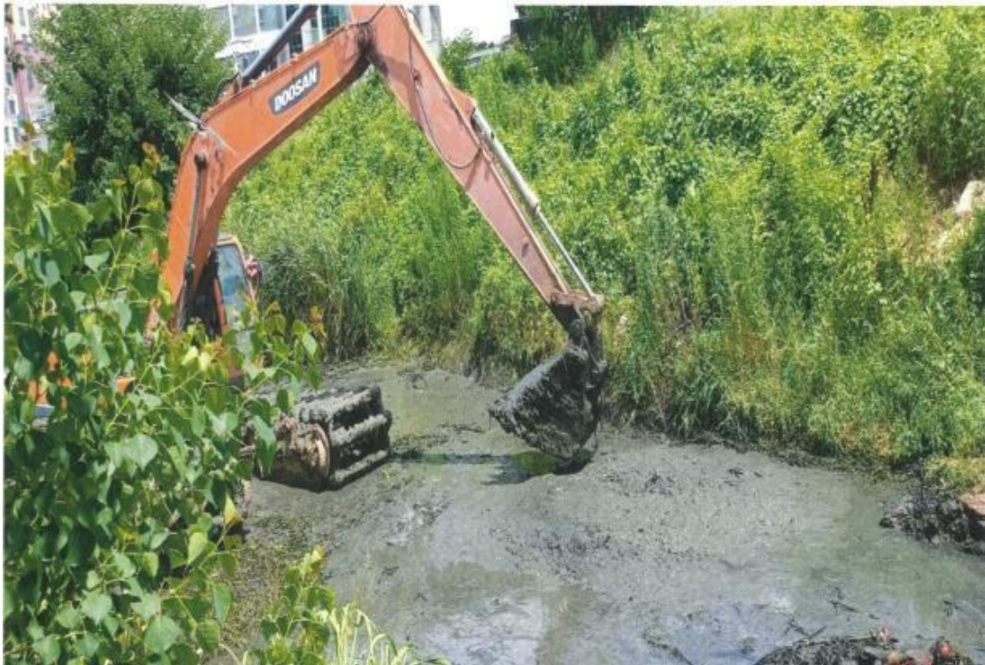
图 4.6 类似项目挖掘机挖淤泥
